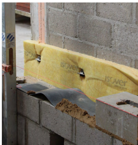
Mise en place de la membrane d'étanchéité
