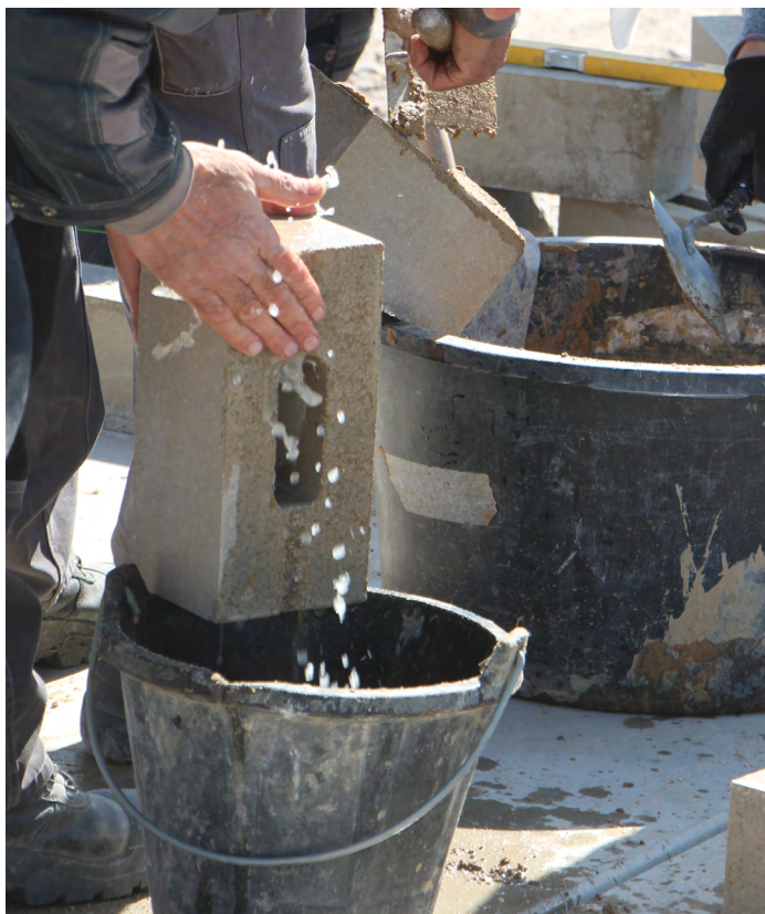
Le Bloc Compressé est mouillé pour une meilleure adhésion au mortier
