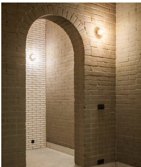
Maçonnerie porteuse en Blocs Compressés
