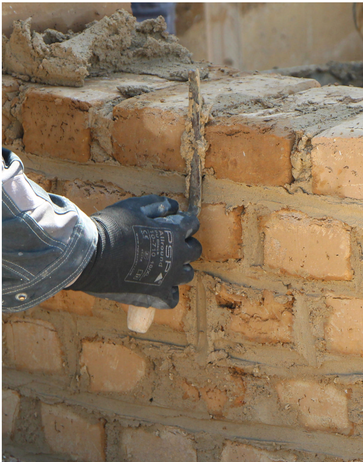
Mise en oeuvre des joints de mortier
