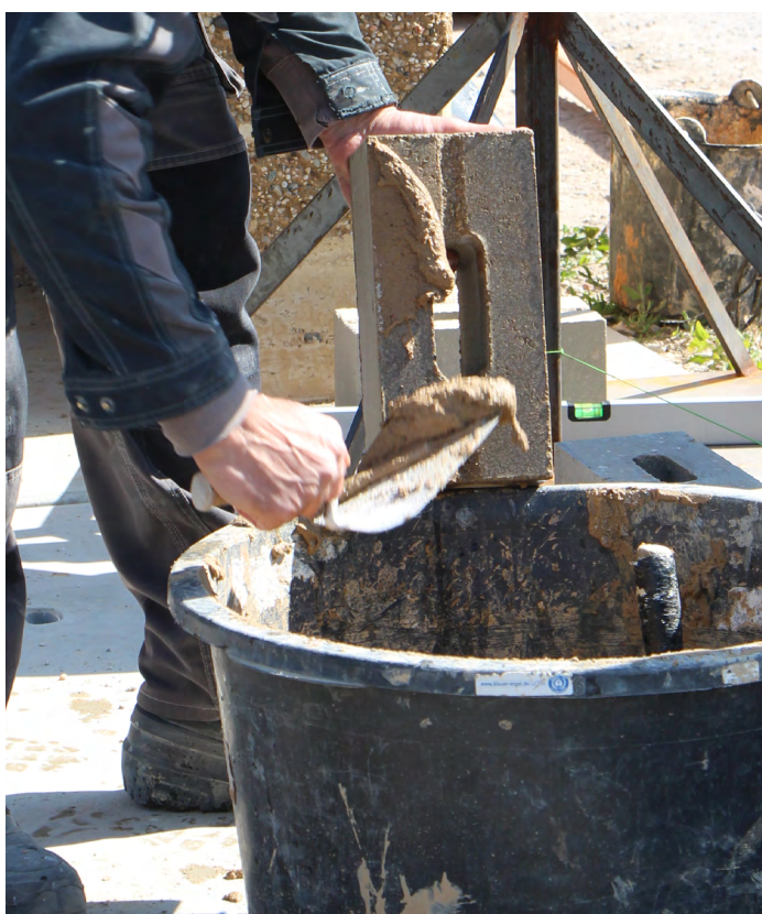
Application du Mortier Colle de Léem
