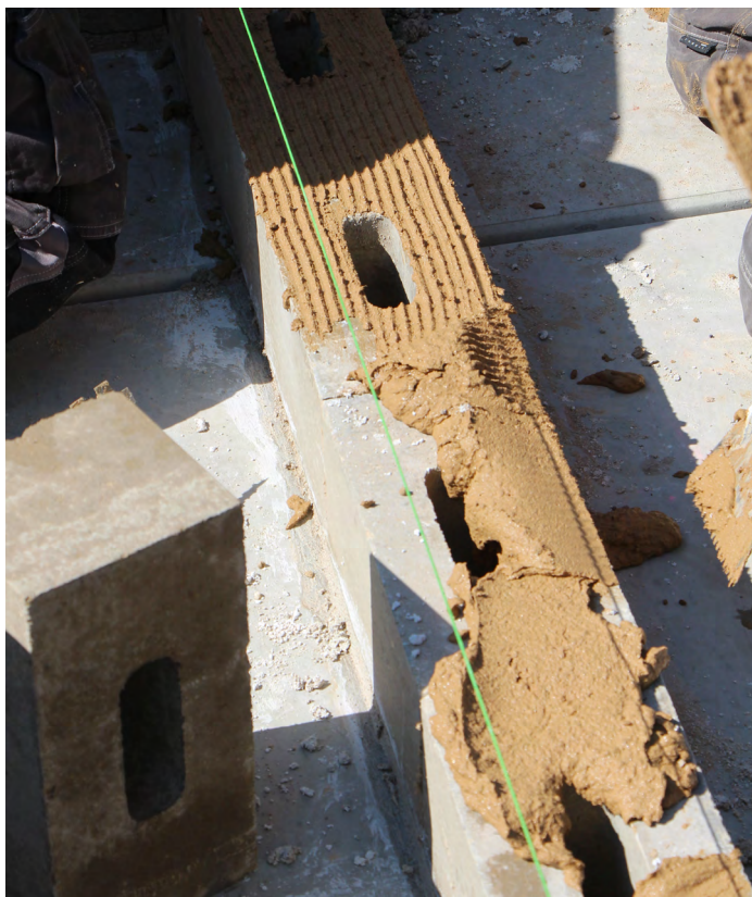
Mise en oeuvre du Mortier Colle de Léem
