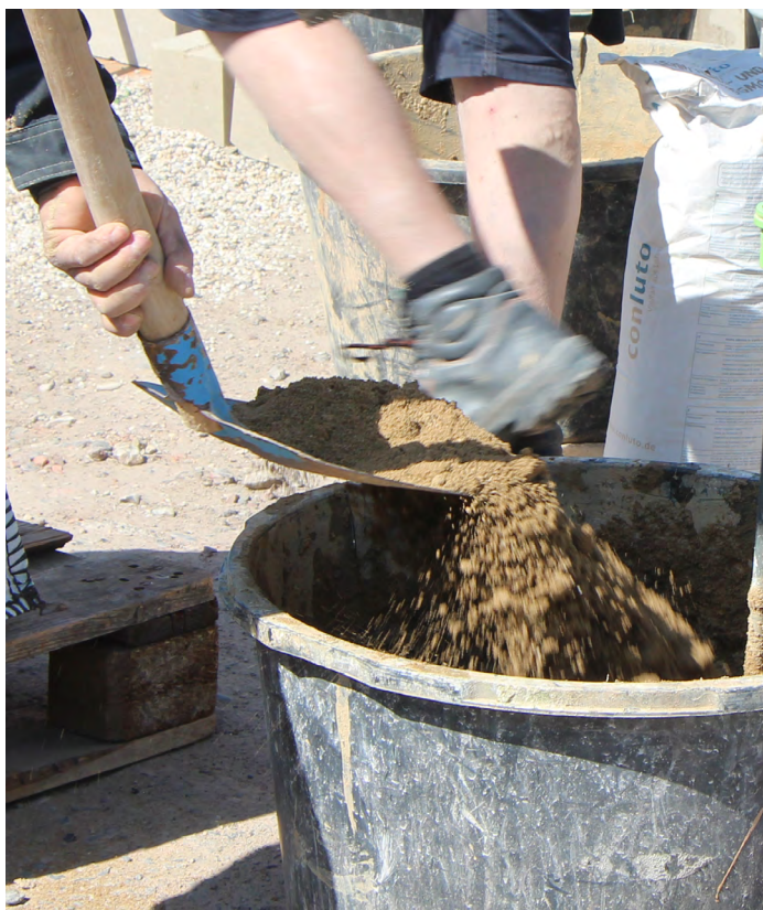
Dosage du Mortier et de l'eau pour le mélange
