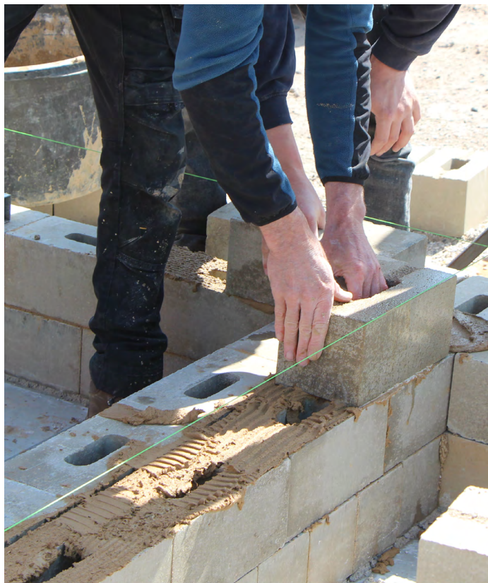
Mise en place du Bloc Compressé
