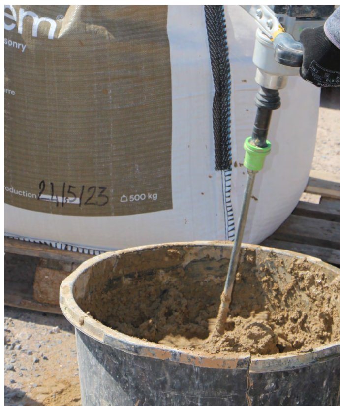
Mélange du Mortier
