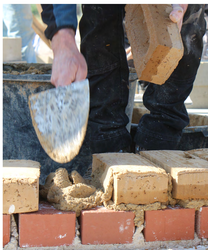
Application du Mortier de Léem
