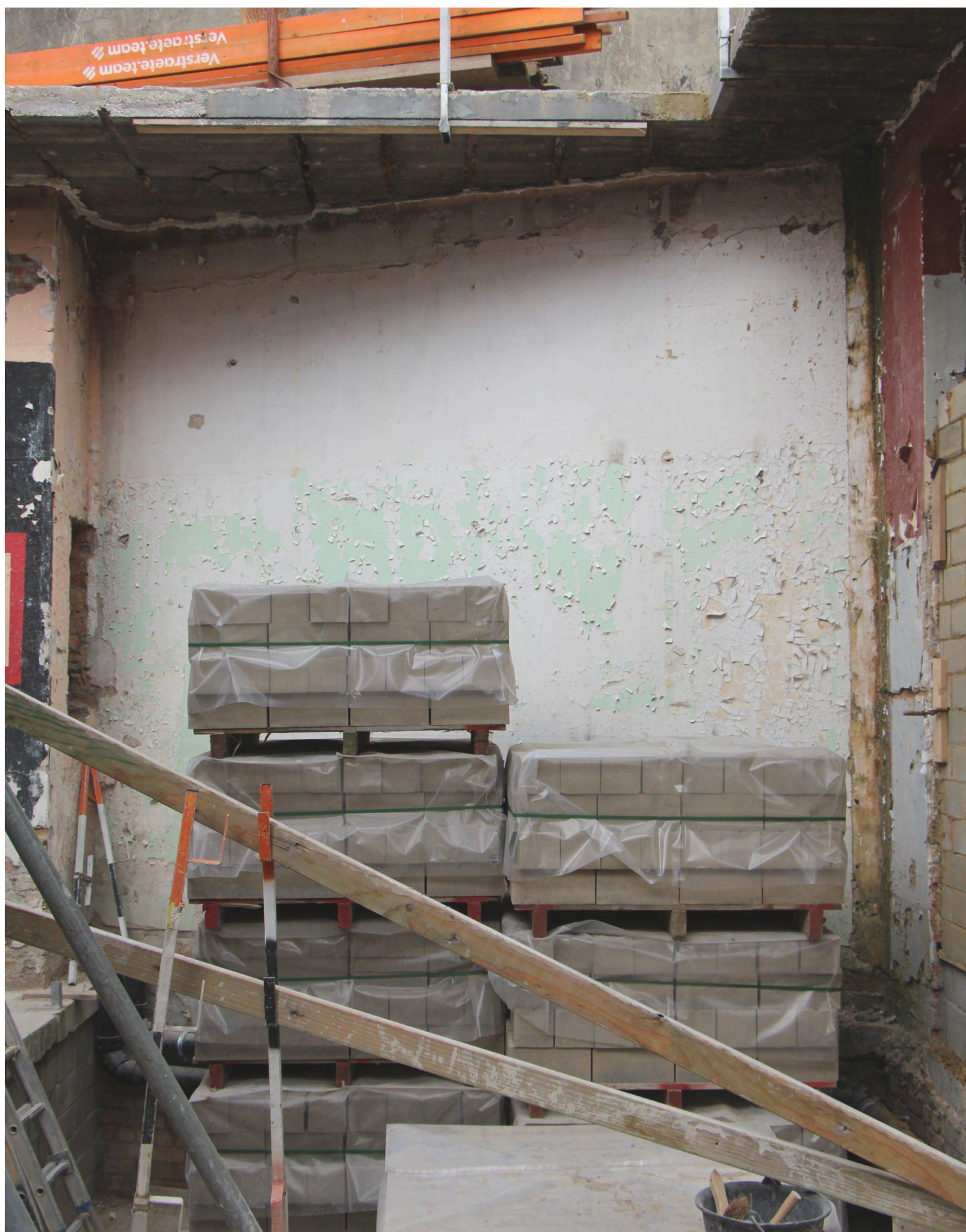
Protection des Blocs Compressés de Léém sur chantier
