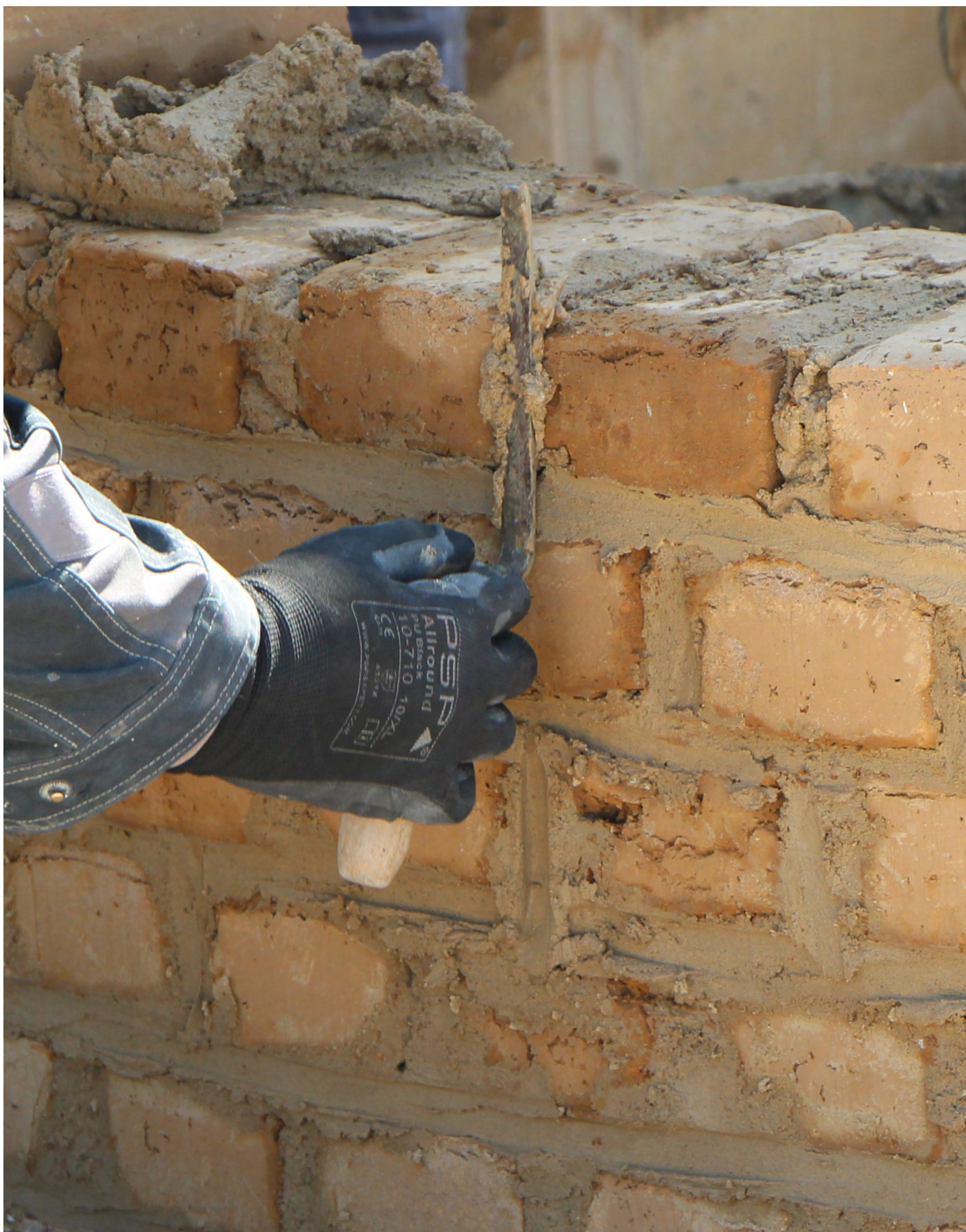
Opvoegen van metselwerk
