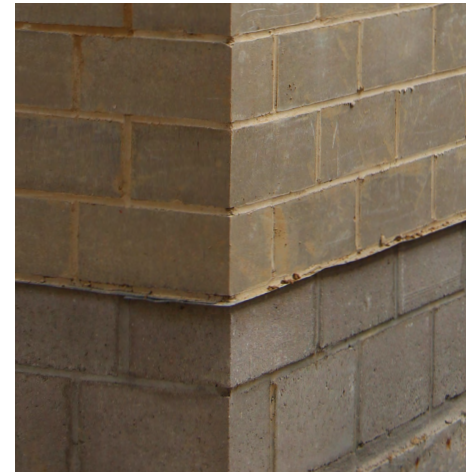
Anti-capillair membraam tussen betonmetselwerk en geperste Léém-blokken
