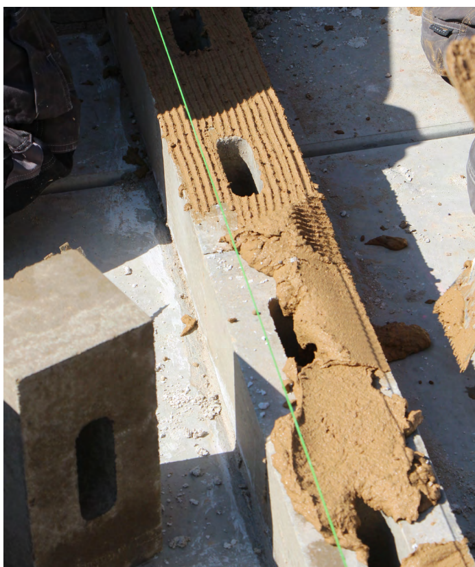
Aanbrengen van Léem Lijmmortel
