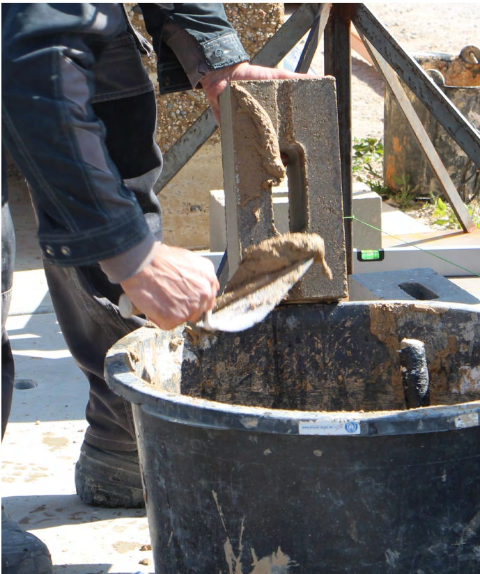
Aanbrengen van Léem Lijmmortel
