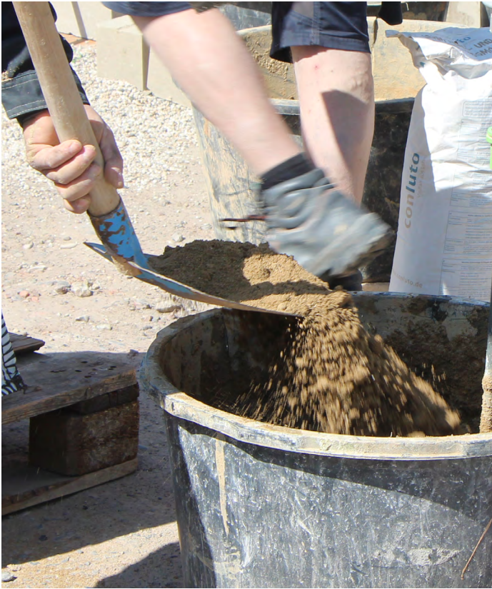
Dosering van mortel en water om te mengen
