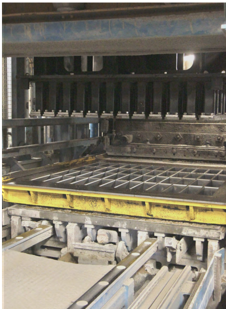
Installatie van mal
