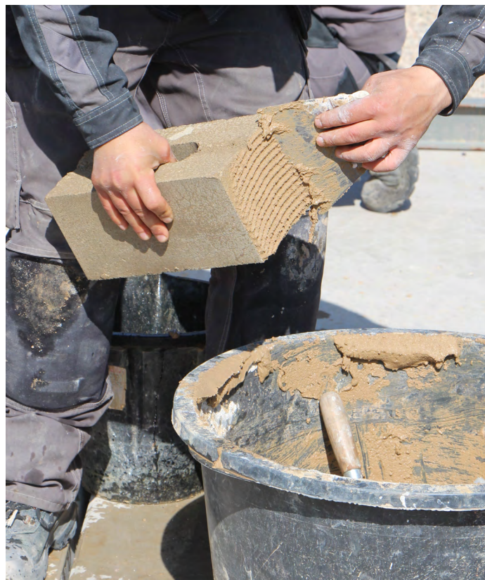
Aanbrengen van Léem Lijmmortel
