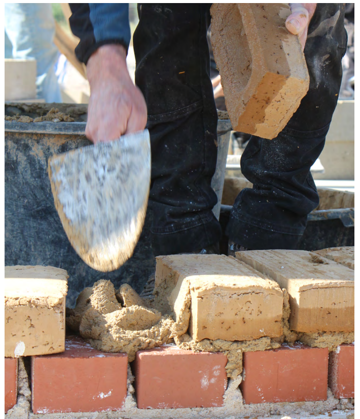
Aanbrengen van Léem Mortel
