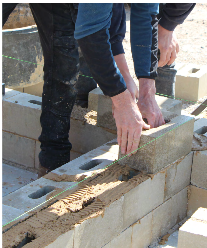
Leggen van een Léem Perssteen op met Léem Lijmmortel
