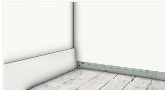
Laat het klikpaneel volledig tegen de muur aansluiten.
