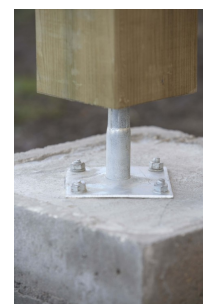
Fixation d'un pied de poteau
