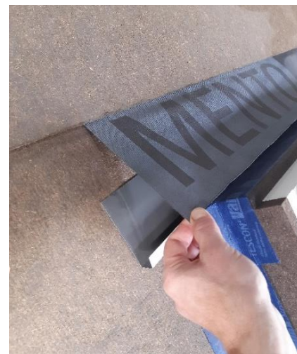
Afb. 13 Voorbeeld van een detail boven een dakraam
