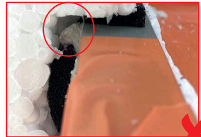
Steeds in stuik werken. Op de hoeken voegdichtband niet aantrekken.
