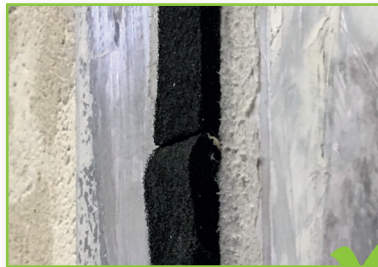
Voegdichtband 15/3-9 mm in stuik toegepast.
