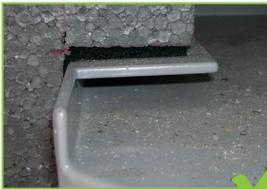
Voegdichtband 15/2-6 mm toegepast.
