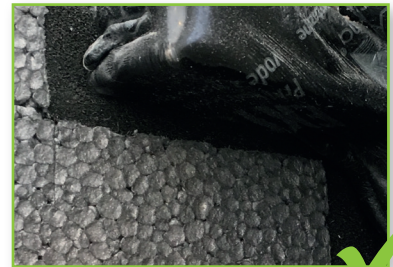
Voegdichtband 30/13-24 mm toegepast.
