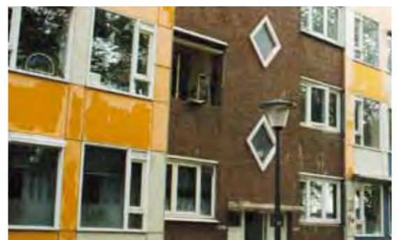
Vóór de renovatie
