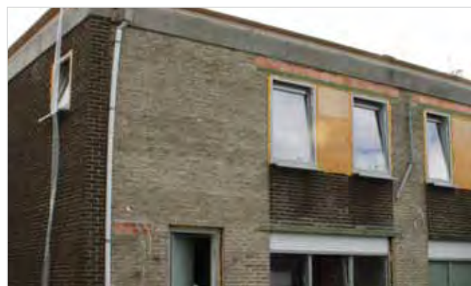
Vóór de renovatie
