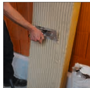
Dämmplatte ankleben auf ebenem Untergrund mit vollflächiger Verklebung
