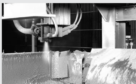
Afbeelding 1.2 : Aanbrengen van de plaatlaag aan de malzijde
