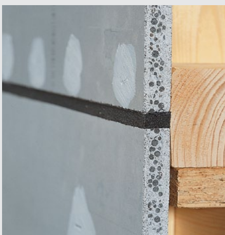
Afbeelding 4.13: Voorgecomprimeerd afdichtingsband voor tijdelijke bescherming tegen weersinvloeden
