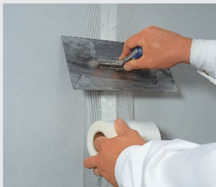
Afbeelding 3.13: Aanbrengen van de fermacell Powerpanel HD Wapeningsband
