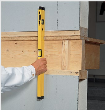
Afbeelding 4.10: Passtellen van de wandelementen
