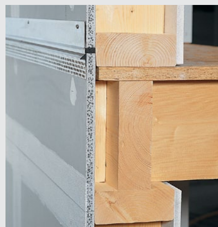
Afbeelding 4.15: Gemonteerde plaatstrook met fermacell Powerpanel HD Vloeraansluitingsprofiel
