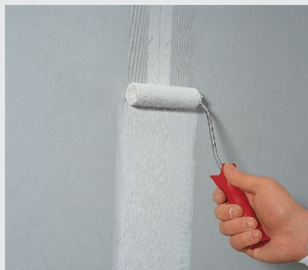
Afbeelding 3.14: Aanbrengen van de fermacell Powerpanel HD Wapeningslijm
