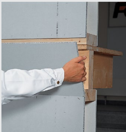
Afbeelding 4.11: Montage van de plaatstroken
