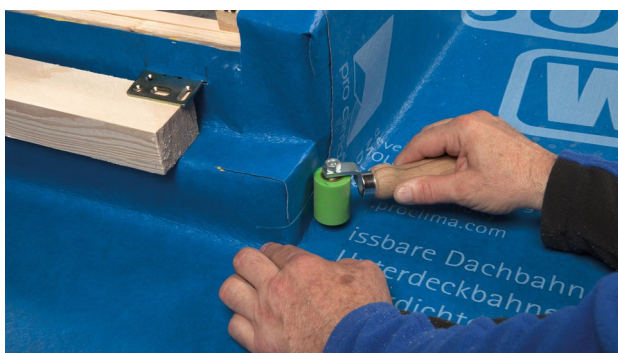
29. Las het stuk SOLITEX WELDANO 3000 vast.
