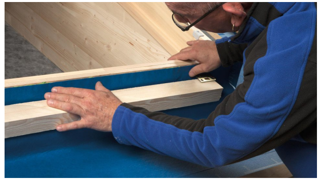
8. Leg SOLITEX WELDANO-S 3000 met een uitzettingslus in de lijmlaag. Druk de lijm daarbij niet helemaal plat, zodat bewegingen kunnen worden opgevangen.
