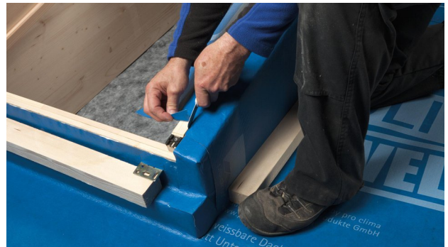
18. Snijd de strook parallel aan het kozijn af. Gebruik een lat als hulpmiddel om de strook zonder vouwen tegen de onderste rand te fixeren.
