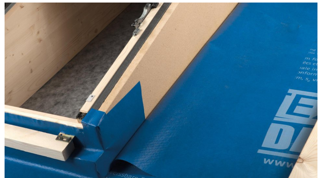
16. De onderste hoek is nu afgedicht.
