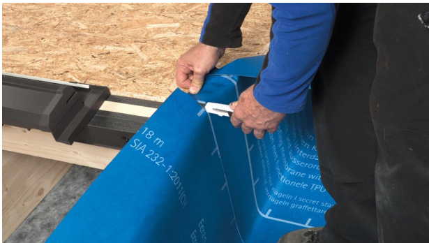
17. Leg de folie tegen de zijkant van het dakraam omhoog. Alternatief kan er ook een nieuwe strook SOLITEX WELDANO 3000 op maat worden gesneden en tegen de zijkant van het dakraam worden gelegd. Deze wordt dan op de onderliggende strook gelast.
