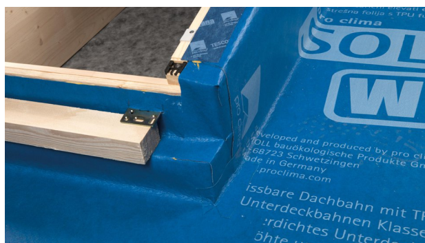
30. De hoek is nu afgedicht.
