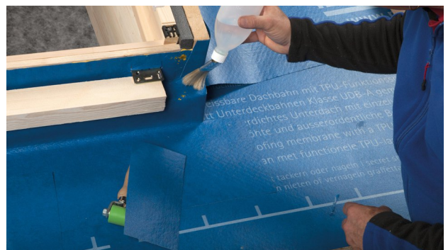
12. Las het stuk bij de hoek aan de onderrand van het kozijn/isolatieframe vast.
