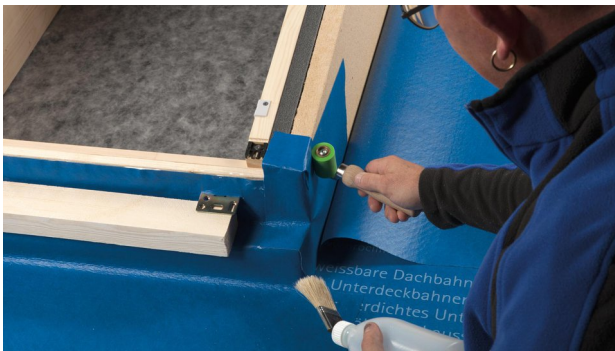
15. Vouw opstaande randen om en las deze aan de onderliggende folie vast. Zorg daarbij dat de hoeken goed zijn afgedicht.
