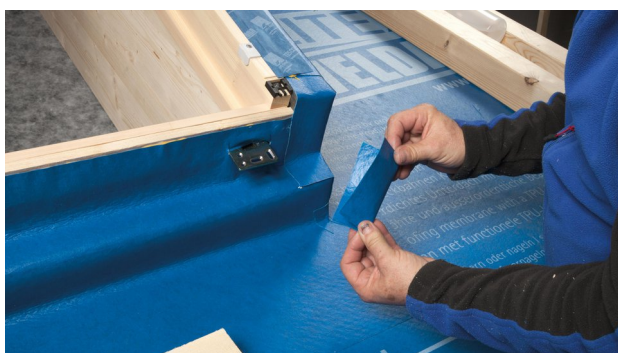
31. Verwijder de steunlat en snijd stukken om de montagehoeken af te dicht.
