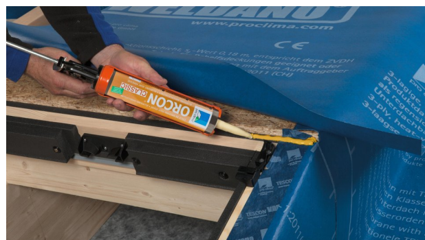
24. Verlijm SOLITEX WELDANO 3000 met ORCON CLASSIC op de bovenste rand van het kozijn.
