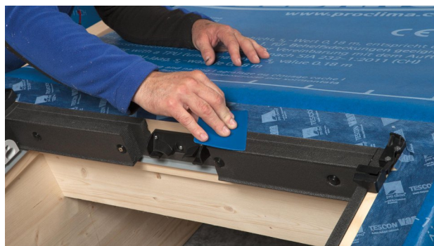
26. Gebruik TESCON VANA om alles te fixeren.
