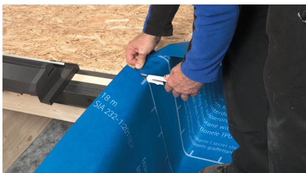
17. Leg de folie tegen de zijkant van het dakraam omhoog. Alternatief kan er ook een nieuwe strook SOLITEX WELDANO 3000 op maat worden gesneden en tegen de zijkant van het dakraam worden gelegd. Deze wordt dan op de onderliggende strook gelast.
