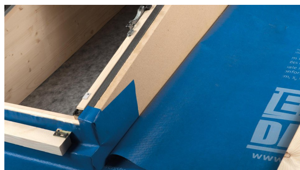
16. De onderste hoek is nu afgedicht.
