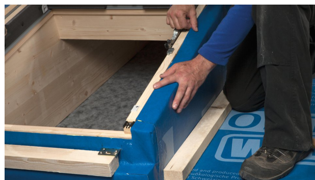
22. Coller SOLITEX WELDANO 3000 le long bord du châssis. Poser l'écran avec une boucle de dilatation dans le lit de colle. Ne pas aplatir complètement la colle, afin de permettre une compensation des mouvements de l'ouvrage.
