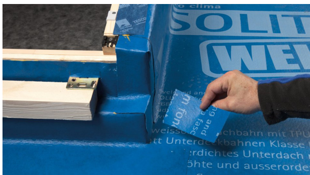
27. Pour recouvrir les bords découpés dans le coin inférieur, découper et poser une petite bande de SOLITEX WELDANO 3000.
