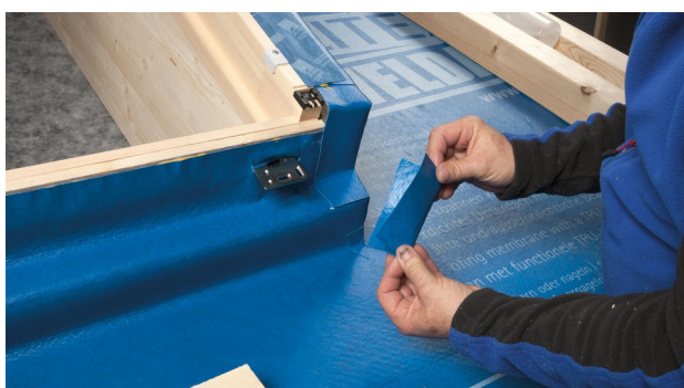
31. Retirer la latte, puis découper des bouts d'écran pour recouvrir les équerres de fixation.
