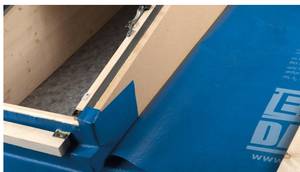
16. L'étanchéité terminée au niveau des coins inférieurs
