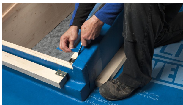
18. Couper l'écran à dimension, parallèlement au châssis de fenêtre. S'aider d'une latte pour bloquer le bord inférieur sans plis.
