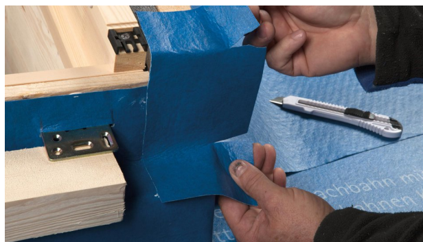
14. Entailler horizontalement le bout confectionné au niveau des deux bords. Au lieu d'entailler le bout jusque sur le châssis, laisser intacts quelques millimètres d'écran qui garantiront l'étanchéité du coin.
