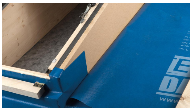
16. L'étanchéité terminée au niveau des coins inférieurs
