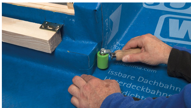
29. Souder la petite bande de SOLITEX WELDANO 3000.
