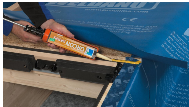
24. Coller l'écran SOLITEX WELDANO 3000 posé à plat sur le châssis de fenêtre supérieur, avec ORCON CLASSIC.
