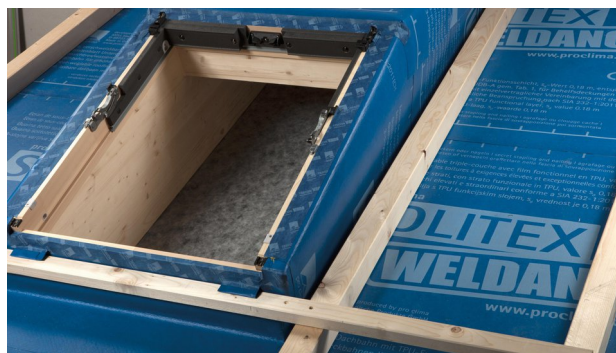
34. Mettre en place le contre-lattage et le lattage porteur, puis visser les équerres de fixation. C'est tout !
