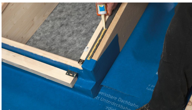
19. Appliquer un cordon de colle système ORCON CLASSIC d'un diamètre de 6 mm sur le châssis.
