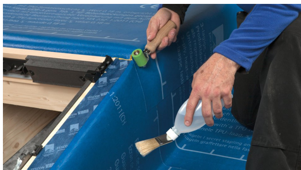
25. Souder les couches de SOLITEX WELDANO 3000 entre elles, sur le côté.
