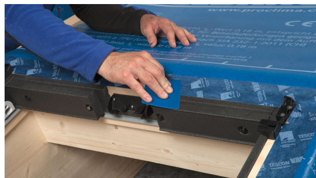
26. Utiliser TESCON VANA pour faciliter le montage et la fixation.
