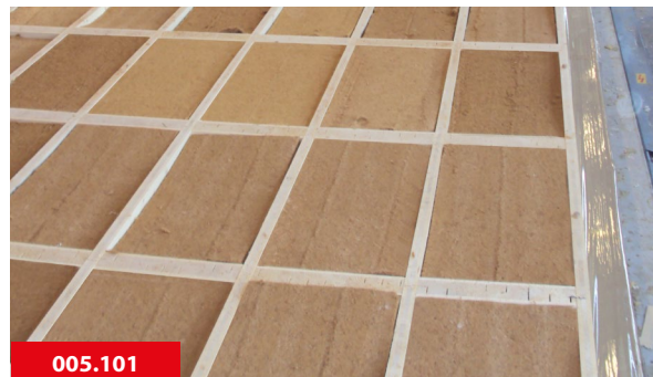
Remplissage avec isolant de fibres de bois.
