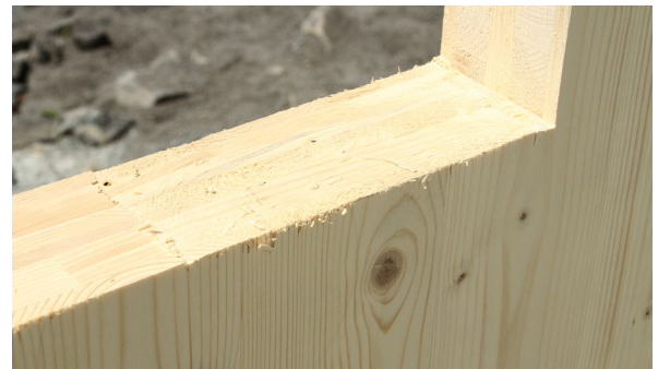
2a. Finition de la découpe par la tronçonneuse – sans rayon (Qualité non visible).
