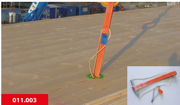
Goujon escamotable (4 pièces pour un ELEMENTS).
