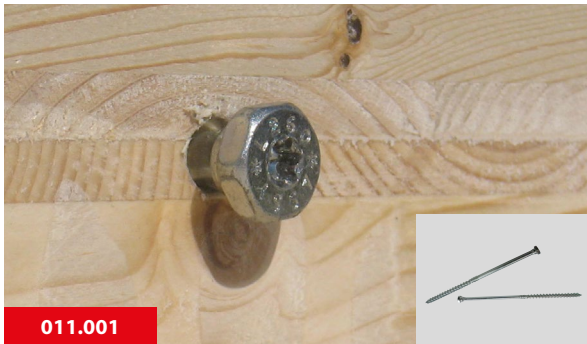
Mise en place de la vis de levage (SOLID).
