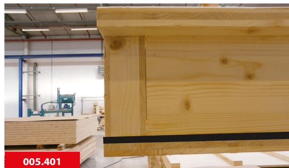
Montage de la bande résistante contre le feu dans la liaison longitudinale.
