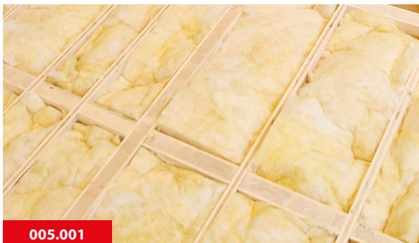
Remplissage de l'isolation minérale.
