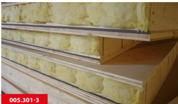
Montage de l'isolation à la liaison longitudinale.
