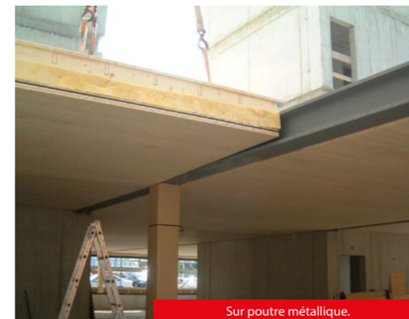
Sur poutre métallique.
