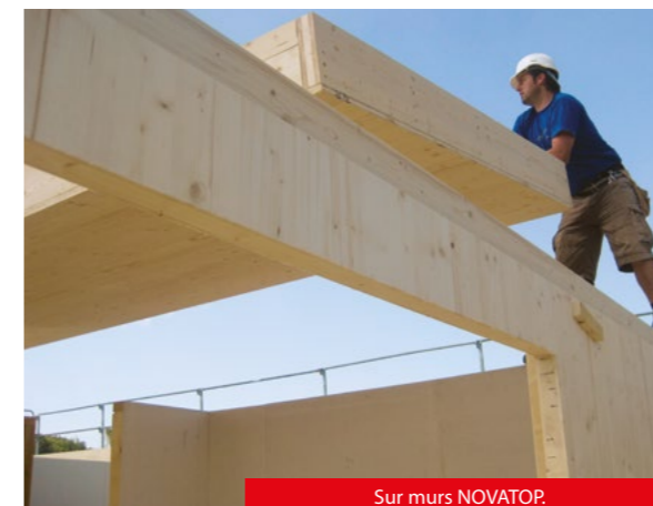
Sur murs NOVATOP.
