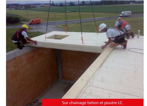
Sur chainage béton et poutre LC.
