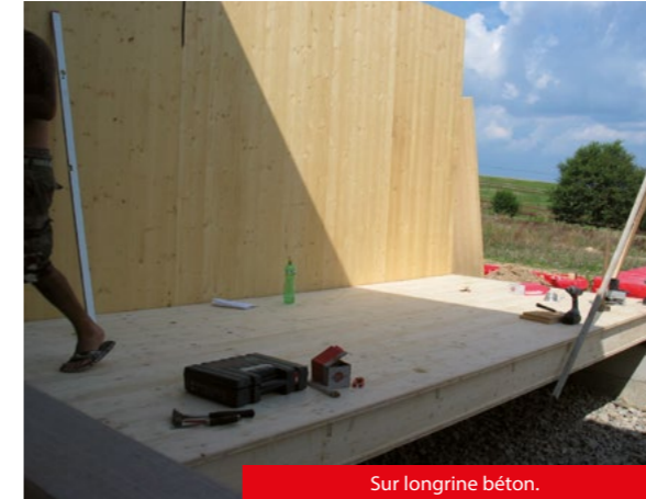
Sur longrine béton.
