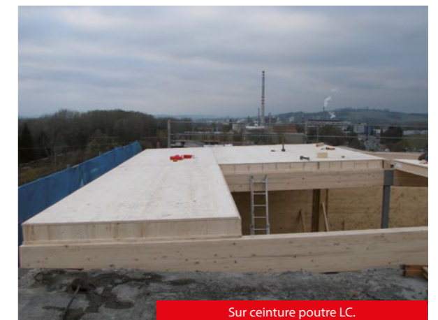
Sur ceinture poutre LC.
