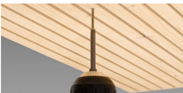
Perçage dans la surface du panneau.
