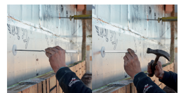
Spouwanker monteren m.b.v. aangepast inslagpijpe (L anker - L plug+10mm)
