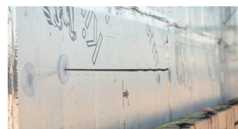
Dualfix inox aisi 304 spouwanker positioneren
