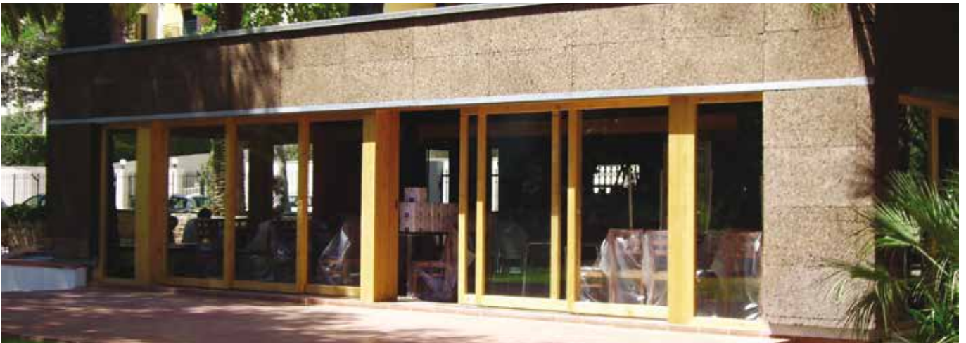
Bar en Estoril, PORTUGAL (Système ETICS (Liège visible))
