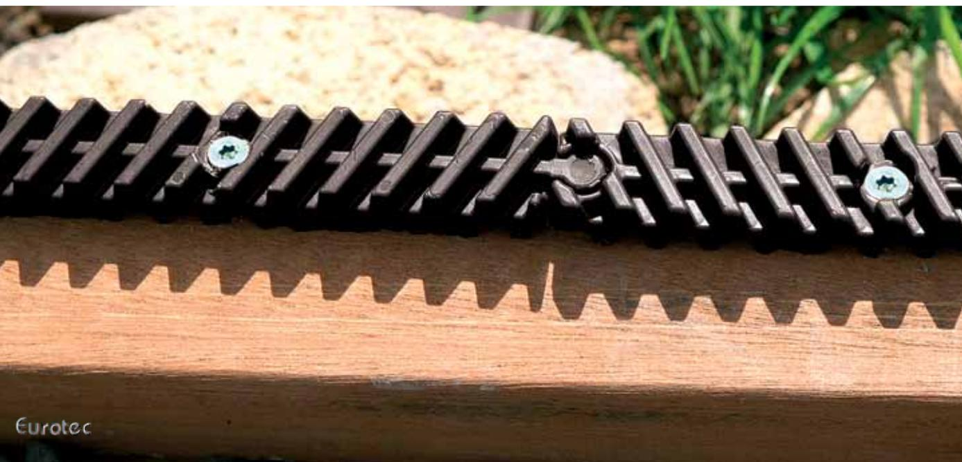
Le liteau d'écartement est vissé sur un demi-côté sur les poutres de soubassement. Un vissage répété du liteau est ainsi évité lorsque la pose des planches de terrasses est entreprise. Dans le cas de poutres de soubassement plus larges, on pourrait recommander de fixer le liteau
