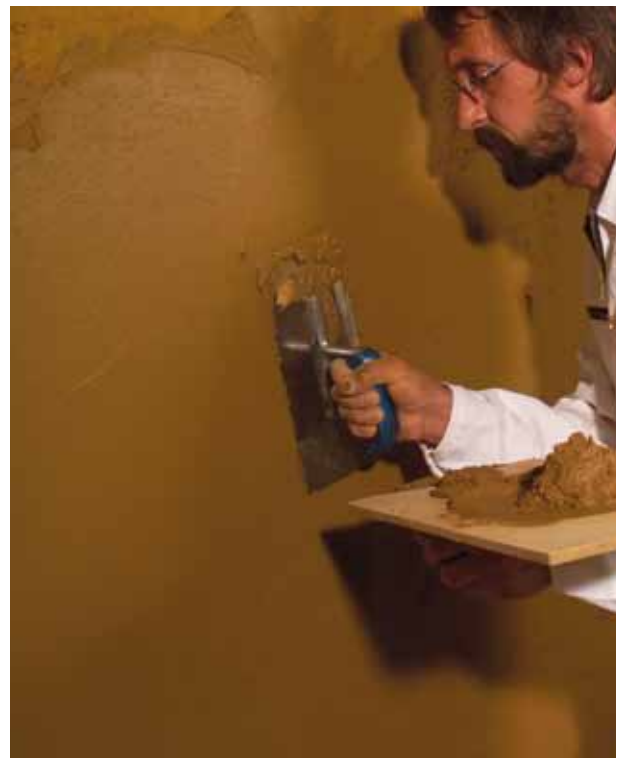
Abbildung 5.3.4: Überspachteln der gesamten Fläche mit Claytec Lehm-Oberputz fein nach abermaligem Vornässen
