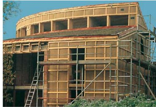
Maison double: toit vert avec 30 cm d'isolation; murs en briques de grand format avec 16 cm d'isolation + panneau de protection de l'isolation Celit 3D
