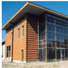
L'isolant contre la brique portante a été recouvert du panneau de protection de l'isolation Celit 3D; bardage en tuiles et mélèze. (Oxfam-Magasins du monde Gent; evr-Architecten)
