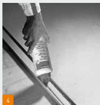
4 Application de la colle
