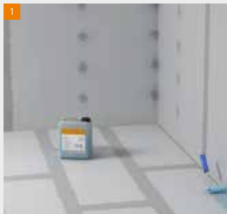
Couche de fond fermacell aux emplacements indiqués...
