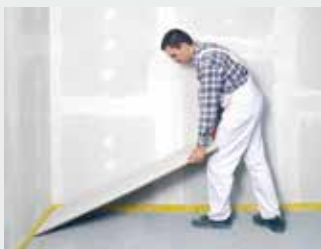
Pose des Plaques de sol
