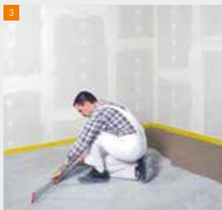
3 Aplanir les granules pour nid-d'abeilles fermacell
