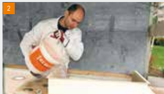
2 Ajouter 8 à 10 litres d'eau par sac
