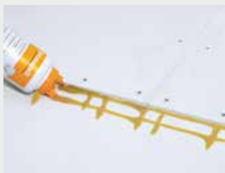
Ruban de colle au bord de la dalle
