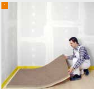
1 Poser les Plaques de sol en nids-d'abeilles fermacell
