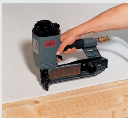
Figure 3.9 : Fixation manuelle par agrafeuse pneumatique
