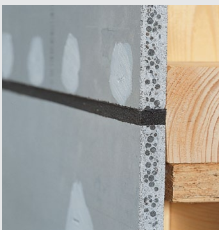
Figure 4.13 : Bande d'étanchéité précomprimée assurant une protection temporaire contre les intempéries
