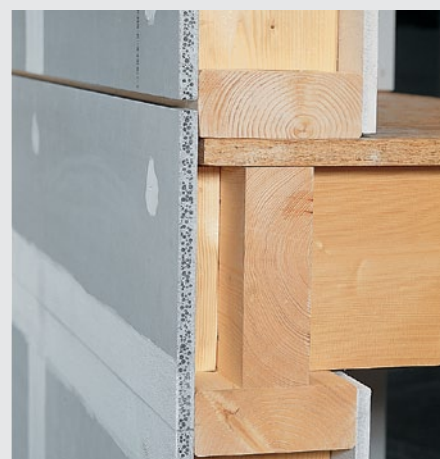
Figure 4.12 : Bande de plaque parachevée à sa base au moyen de la technique de jointoiment
