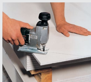
Figure 3.4 : Utilisation d'une scie sauteuse pour les arrondis et les adaptations
