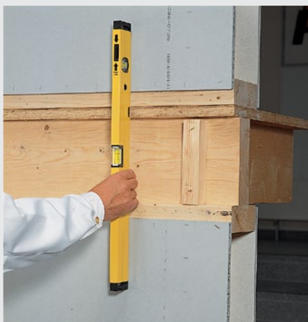
Figure 4.10 : Alignement des éléments de la paroi
