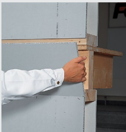
Figure 4.11 : Montage des bandes de plaque
