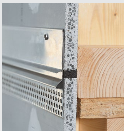
Figure 4.14 : Bande d'étanchéité précomprimée assurant une protection temporaire contre les intempéries, avec profil de recouvrement de sol fermacell Powerpanel HD
